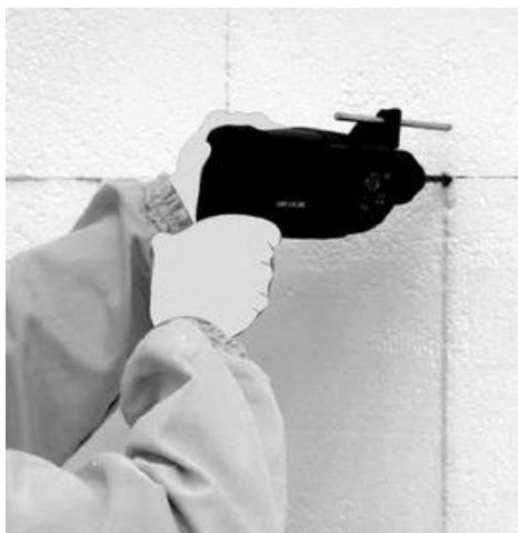
Рисунок 14 – Сверление отверстий электродрелью
