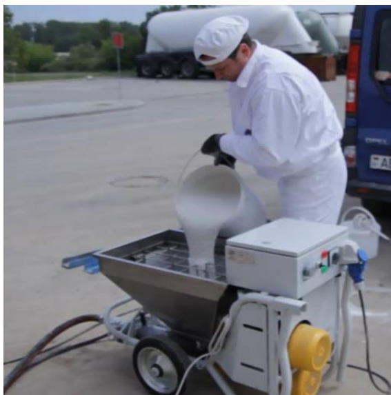
Рисунок 21 - Заполнение бункера штукатурного агрегата
