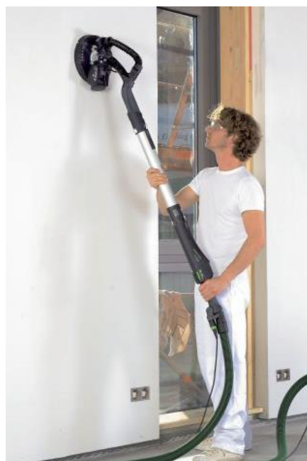
Рисунок 24 – Механизированное шлифование
