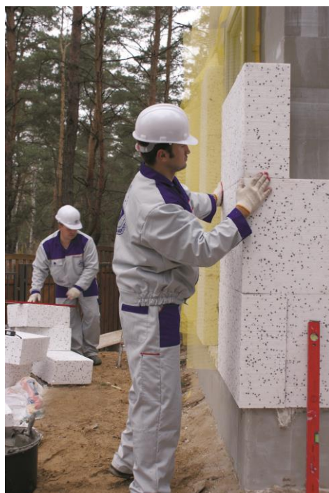
Рисунок 10 – Перевязка плит на углу здания
