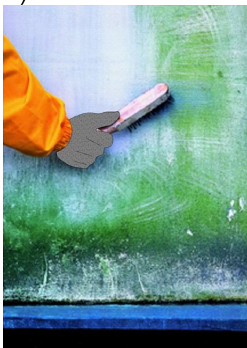
Рисунок 5 – Подготовка поверхности подосновы
