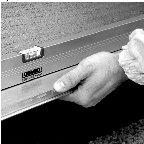
Рисунок 6 – Разметка мест установки цокольных планок
