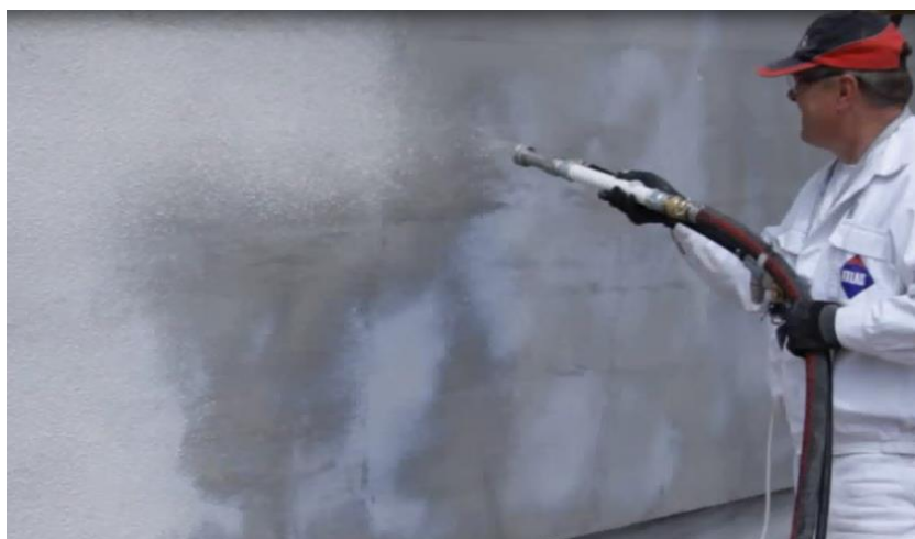
Рисунок 22 – Нанесение защитно-отделочного штукатурного состава
