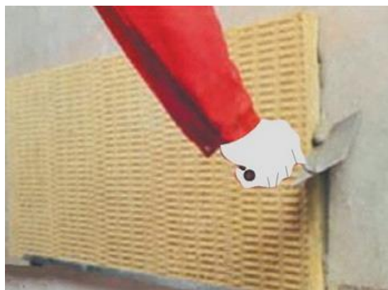
Рисунок 11 – Удаление лишнего клея
