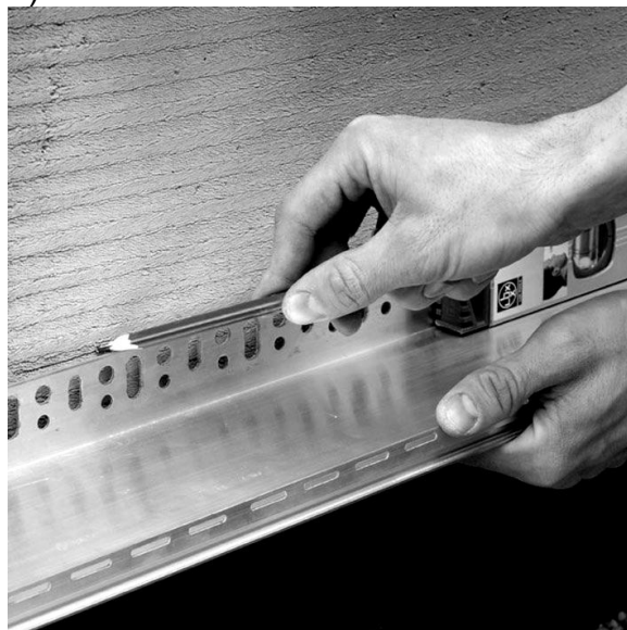
Рисунок 6 – Разметка мест установки цокольных планок
