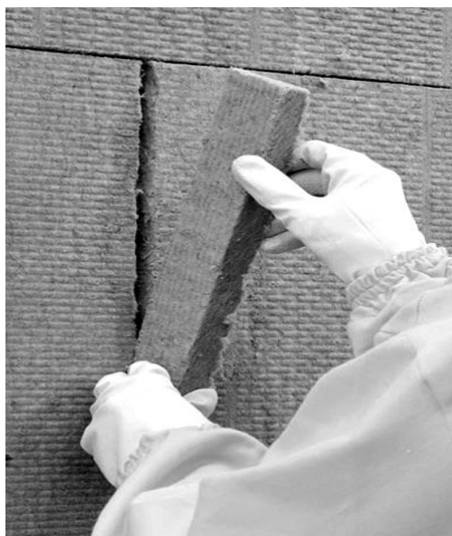
Рисунок 12 – Заделка щелей между теплоизоляционными плитами
